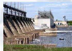
Travaux mécanique à la centrale Carillon Hydro Québec, Saint-André d'Argenteuil
