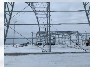
Installation de la structure d'acier de deux hangars à avion (Dômes) Airbus Bombardier, Mirabel
