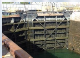
Réfection structurale et mécanique de portes d'écluse Corporation de la voie maritime, St-Lambert
