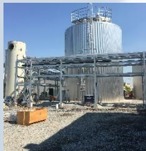
Fabrication et installation de 5000pi de tuyauterie de procédé et haute pression Usine de Biométhanisation SEMECS, Varenne
