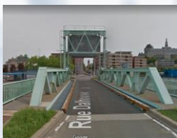
Réfection mécanique et structural du Pont à Bascule Port de Québec, Québec
