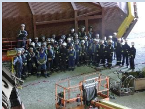
Remplacement de la hotte du convertisseur Rio Tinto, Sorel
