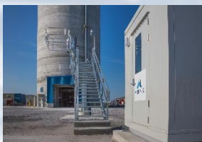
Installation de tuyauterie et de structure du terminal maritime Ciment McInnis, Ste- Catherine
